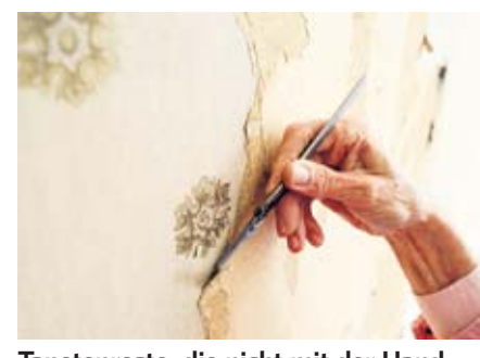
Tapetenreste, die nicht mit der Hand abgezogen werden können, müssen mit dem Skalpell gelöst werden
